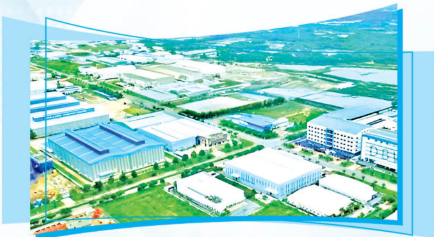
Khu công nghiệp Thuận Yên/ Thuan Yen Industrial Zone
