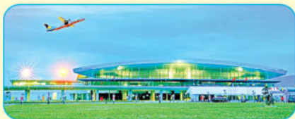
Đầu tư mở rộng nhà ga cảng hàng không quốc tế Phú Quốc, tỉnh An Giang Investment in the expansion of Phu Quoc International Airport terminal, An Giang province
