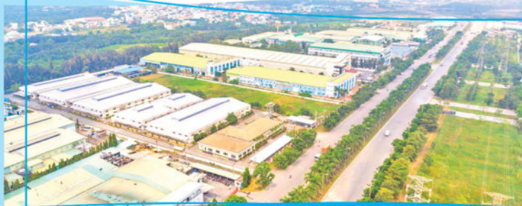
Khu công nghiệp Thạnh Lộc/ Thanh Loc Industrial Zone
