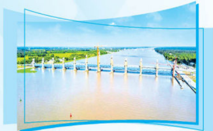
Công trình ngăn mặn cống Cái Lớn - Cái Bé Cai Lon - Cai Be Saltwater Control Project
