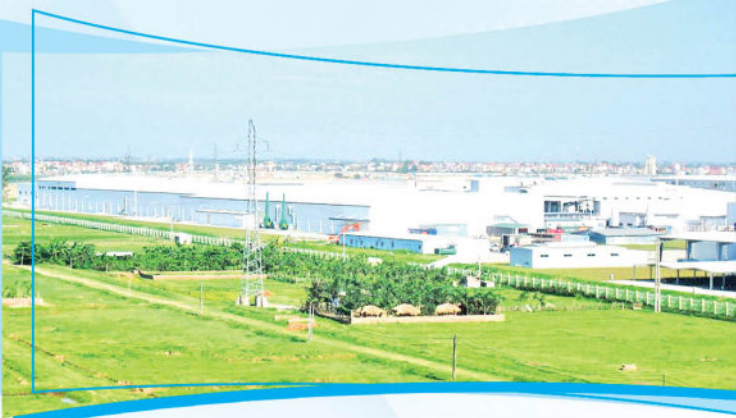
Khu công nghiệp Thuận Yên/ Thuan Yen Industrial Zone
